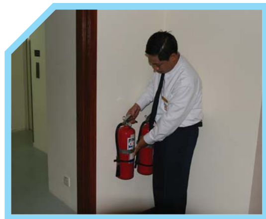
CÁC LOẠI BÌNH CHỮA CHÁY KHÁC NHAU
