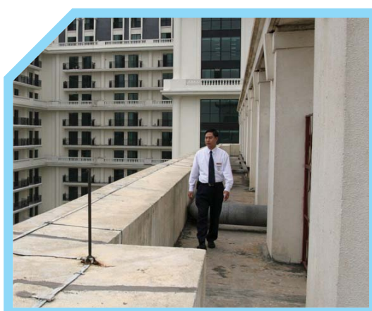
KIỂM TRA MÁI NHÀ
